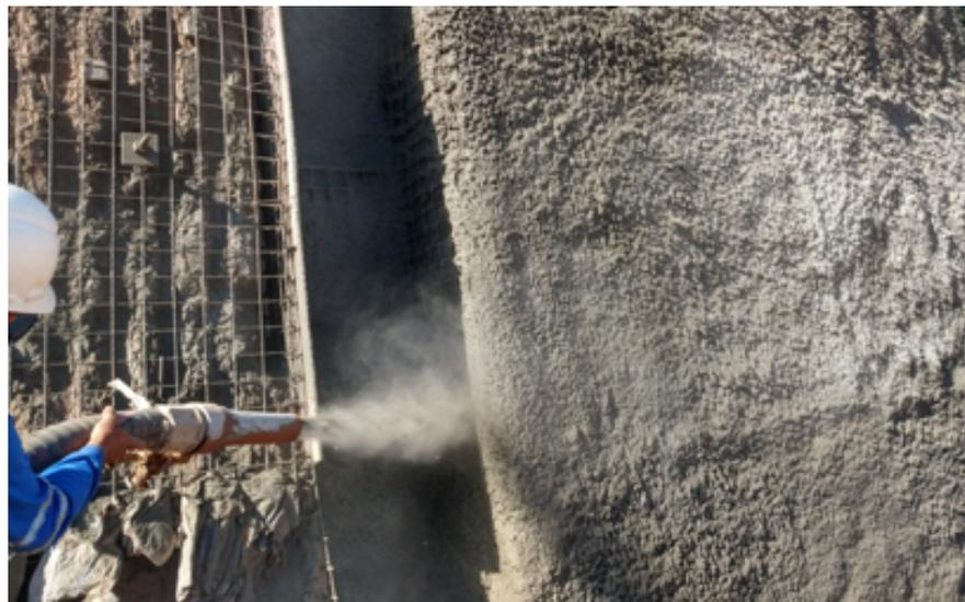
Figura 18: execução da descida d'água em degraus com concreto projetado
