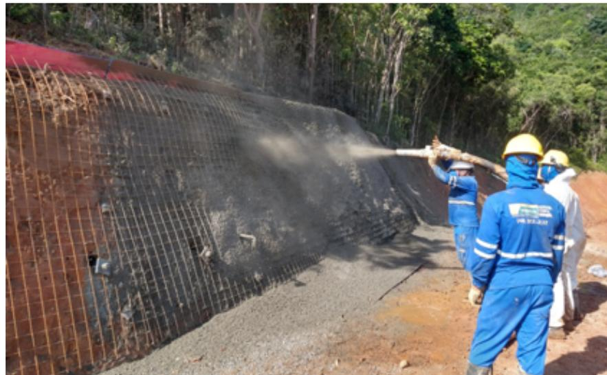
Figura 11: projeção do concreto na primeira linha de grampos
