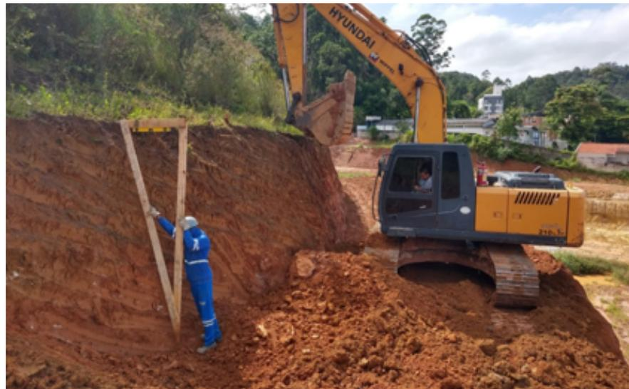
Figura 4: escavação do terreno com preparação do talude e do patamar de trabalho inicial
