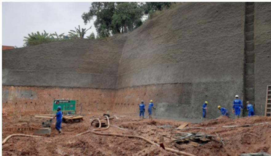
Figura 20: andamento da contenção com aplicação de concreto projetado
