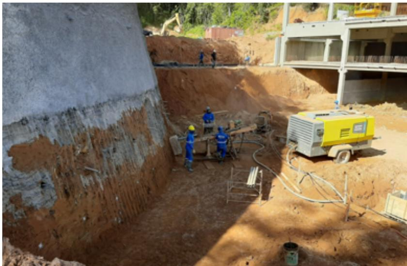
Figura 17: perfuração dos grampos nas etapas finais em simultaneidade à montagem da estrutura pré-moldada do empreendimento
