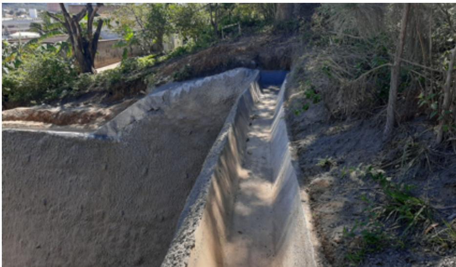
Figura 23: calha de drenagem da crista pronta
