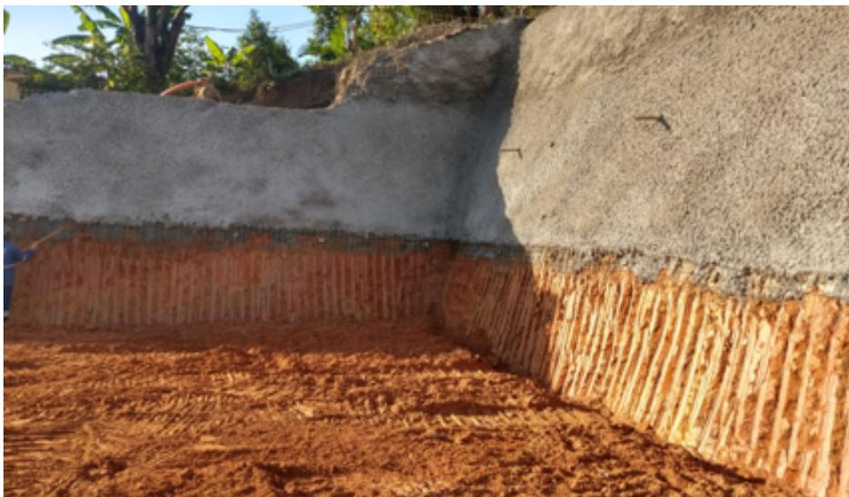
Figura 12: escavação e preparação do talude para o próximo alinhamento de grampos
