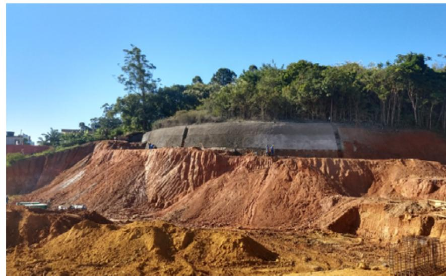
Figura 16: vista frontal da contenção em solo grampeado em andamento
