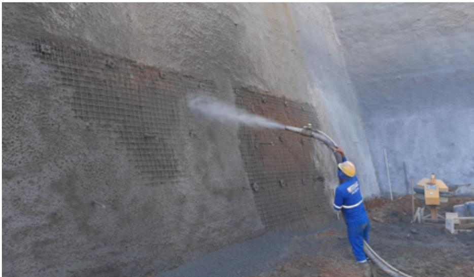
Figura 21: detalhe do concreto projetado em execução
