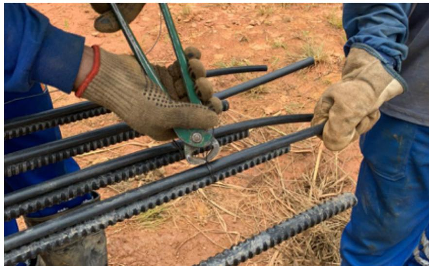
Figura 6: montagem dos grampos
