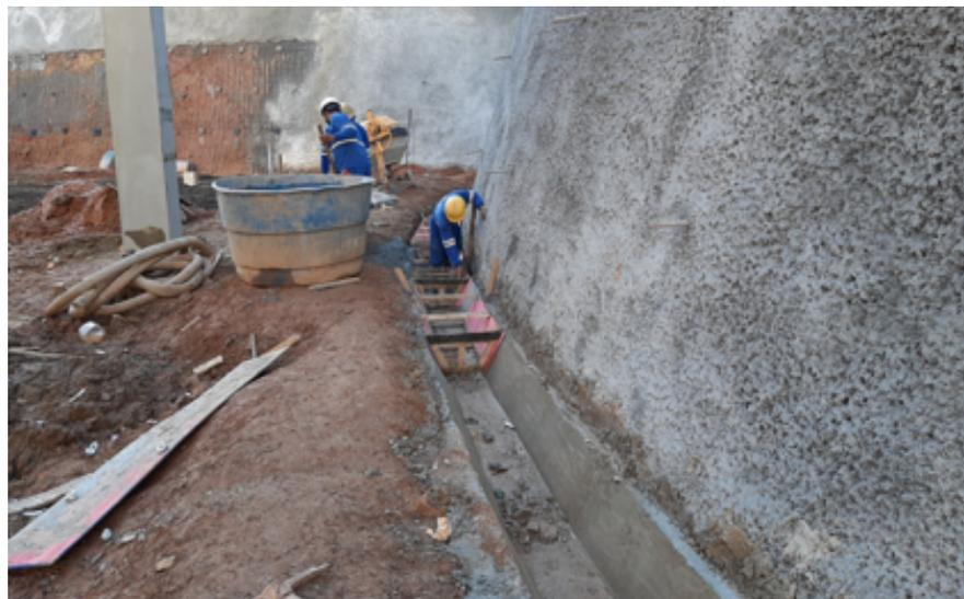
Figura 24: execução da calha de drenagem na base da cortina
