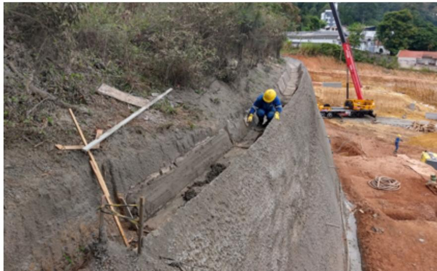
Figura 22: confecção da calha de drenagem na crista da cortina
