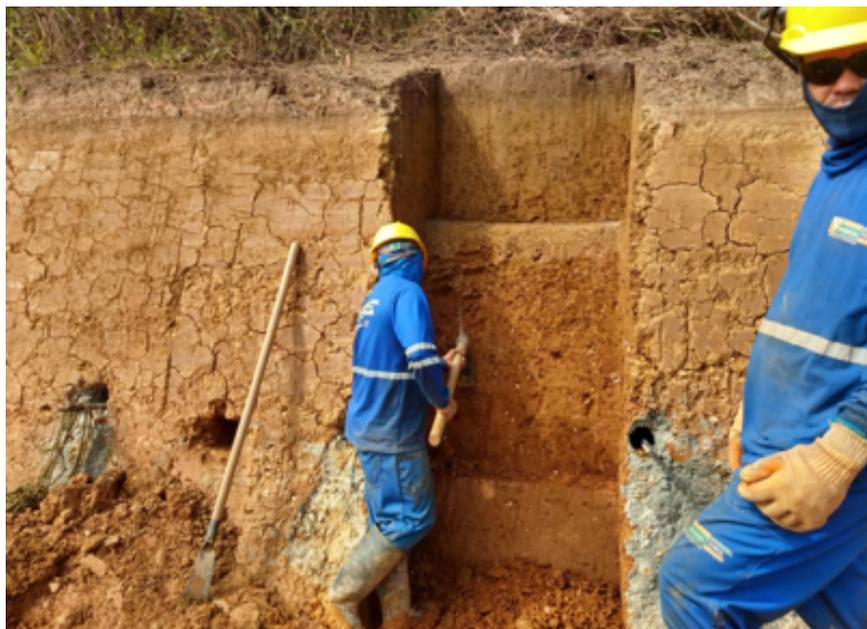
Figura 8: escavação e preparação da descida d'água em degraus
