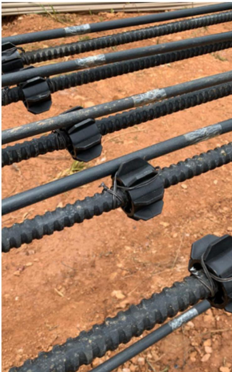
Figura 7: detalhe dos grampos montados com espaçador e mangueira de injeção
