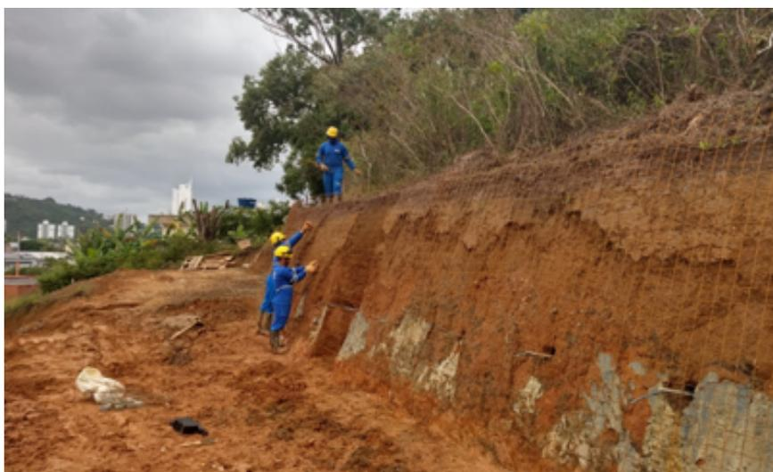
Figura 9: instalação das telas e drenos superficiais [barbacãs]
