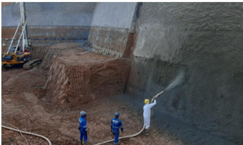
Figura 19: aplicação do concreto na face do talude
