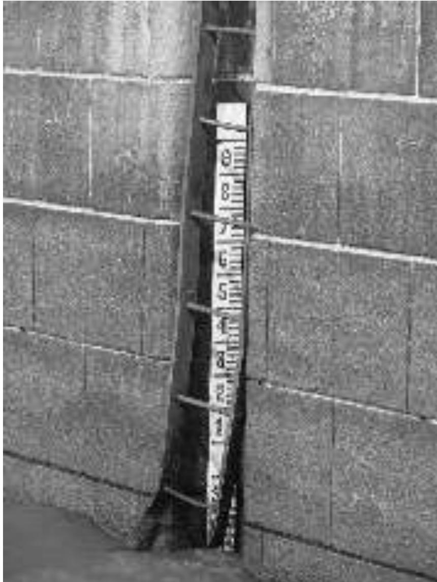
**Figura 2** – Régua instalada pela Superintendência de Portos e Hidrovias.
