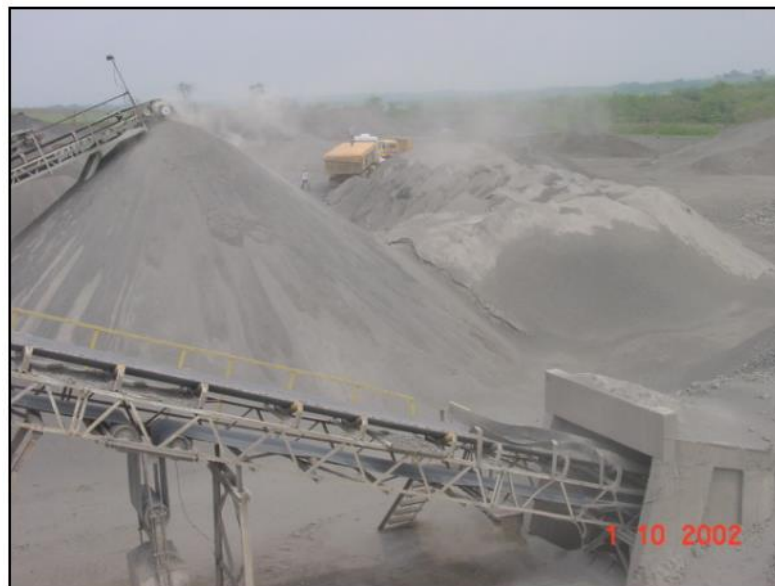
Figura 2: Depósitos de pó de pedra
