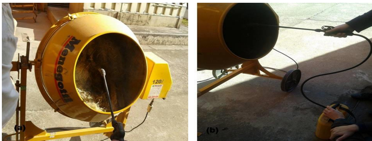
Figura 18. Material sendo misturado na betoneira
