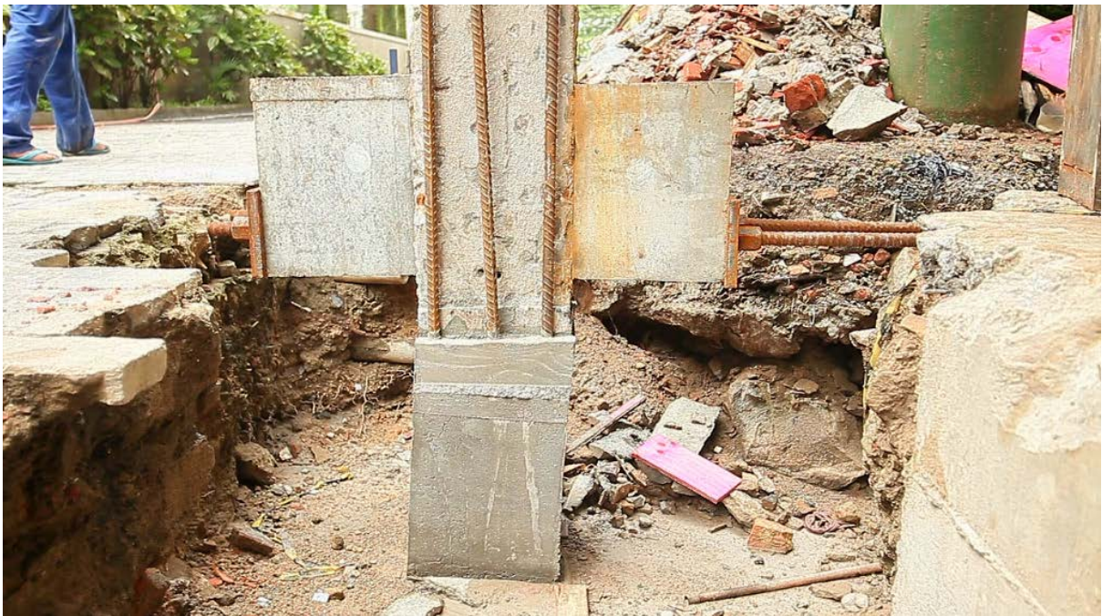
8 – RECONSTRUÇÃO DOS PILARES
