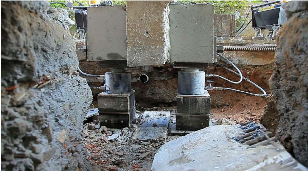
5 – MACACOS AUXILIARES PARA CORTE DOS PILARES.
