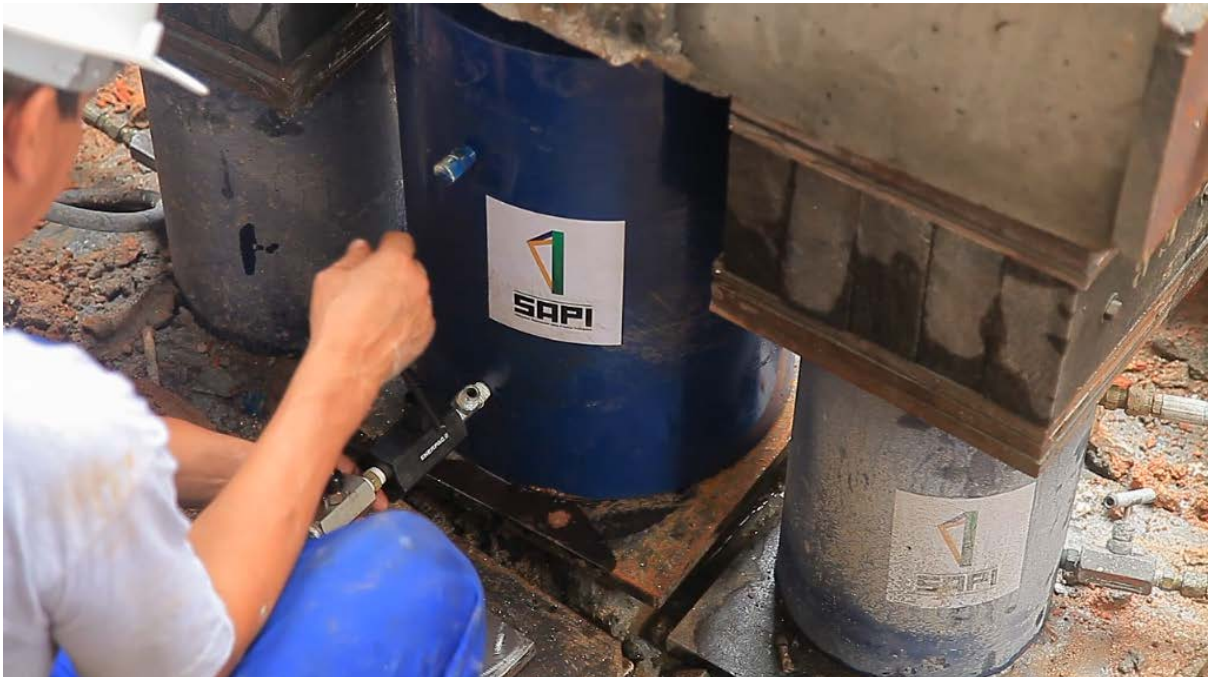
6 – INSTALAÇÃO DOS MACACOS PRINCIPAIS.
