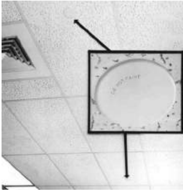
Figura 41 – Bico Oculto não Ferroso em Forro
