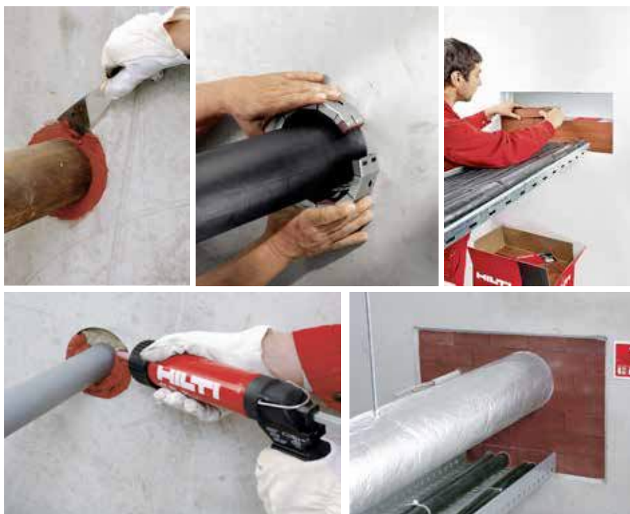
Figura 26 – Aplicação de selagens corta-fogo e fumaça
