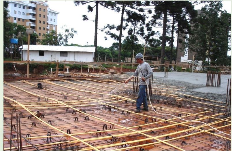
Molhagem da fôrma
