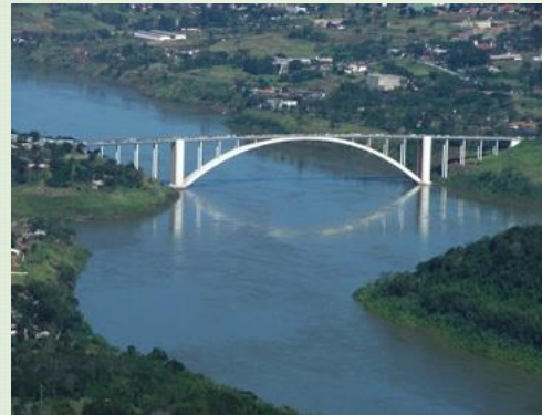
Ponte da Amizade - PR
