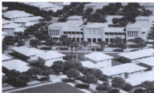
Comunidade de Jordan Commons. Flórida, EUA. O uso do pavimento de concreto e a arborização podem reduzir a temperatura em 5°C.
