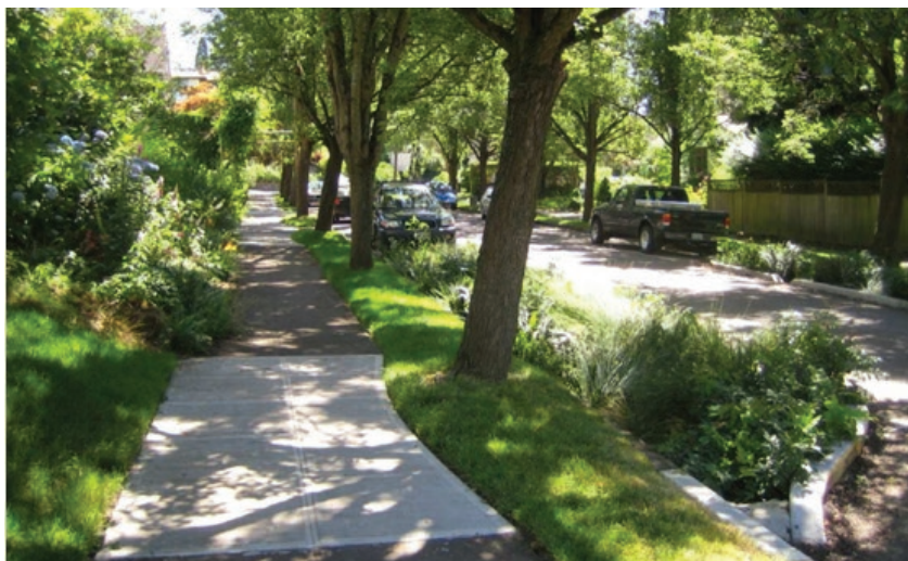
Jardim de chuva da Rua Siskiyou, Portland.
