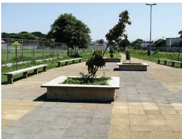
Aplicação de diferentes tipos de piso (borracha, permeável e intertravado) no Parque Linear Água Vermelha, Itaim Paulista, São Paulo.
