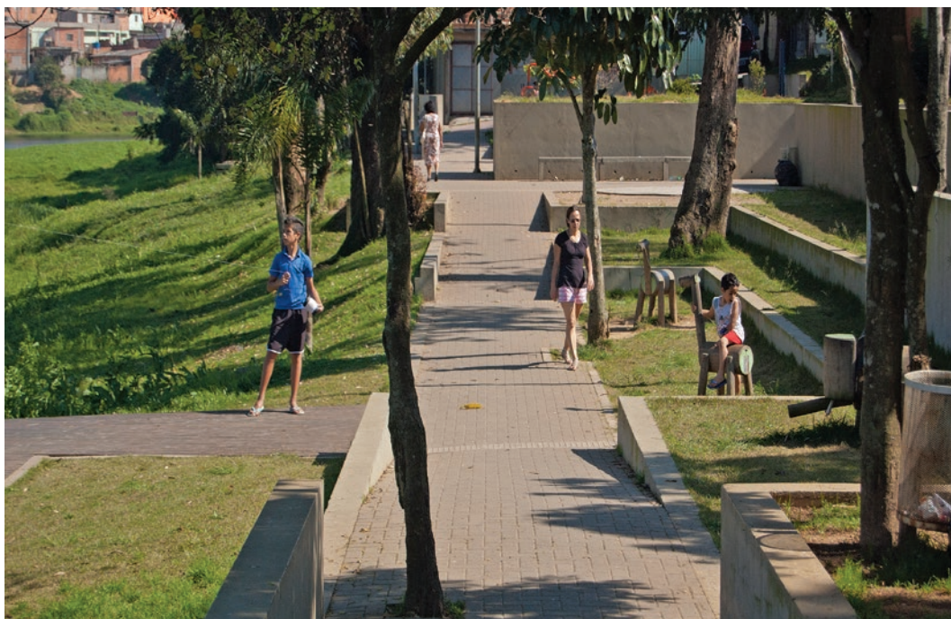
Canteiros formando bancos no Parque Cantinho do Céu, SP. Projeto: Boldarini Arquitetura e Urbanismo.
