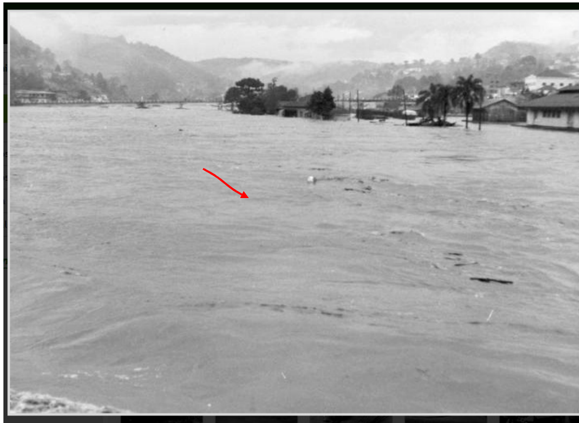
Enchente de 1983 : Ponte Jorge Lacerda ( a montante da ponte Emilio Baumgart )
