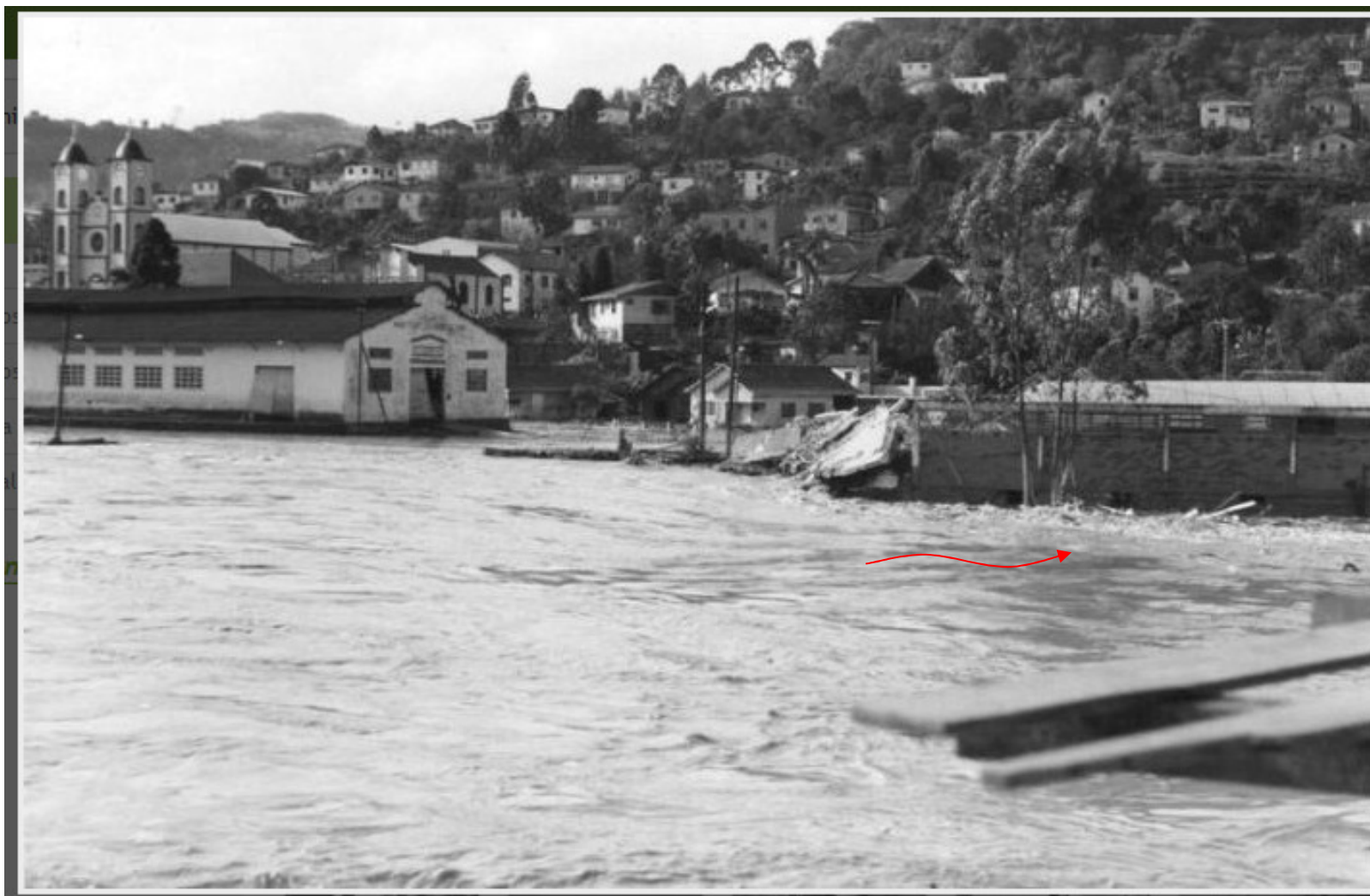
Enchente de 1983 : “... AFINAL, ... SEM A PONTE E ... SEM O PRÉDIO”
