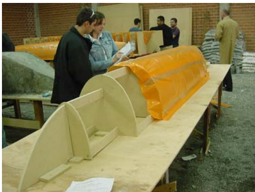
Figura 9 - Forma interna em lona com esqueleto de madeira.
