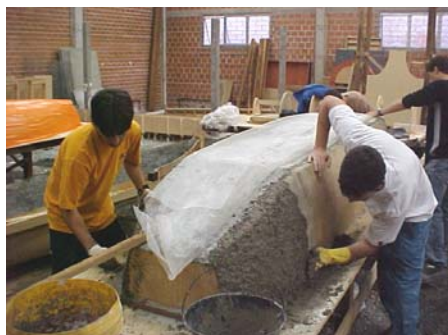
Figura 17 - Execução da canoa da Equipe 6.
