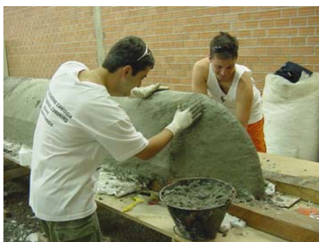
Figura 14 - Execução da canoa da Equipe 3.
